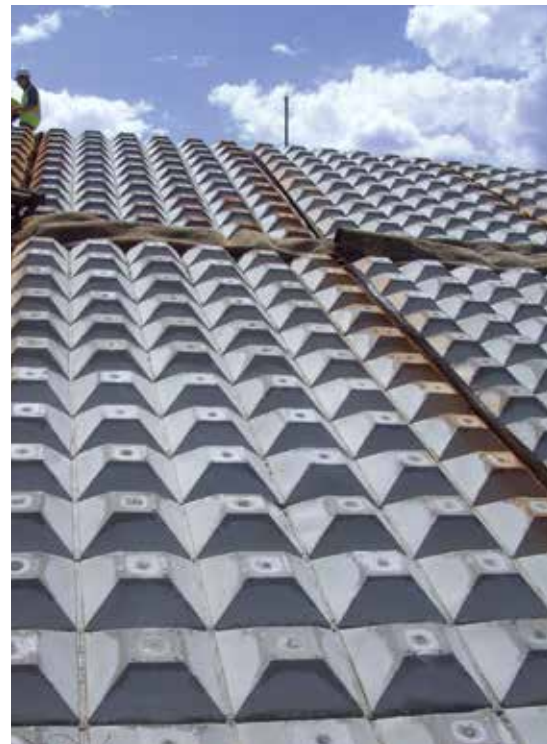
The Roy Hill projesinde TechFlex ile erozyon kontrolü.
