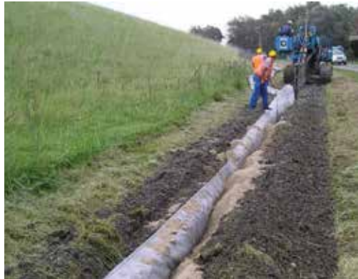
Yol inşaatlarında TechDrain ile drenaj sistemi.
