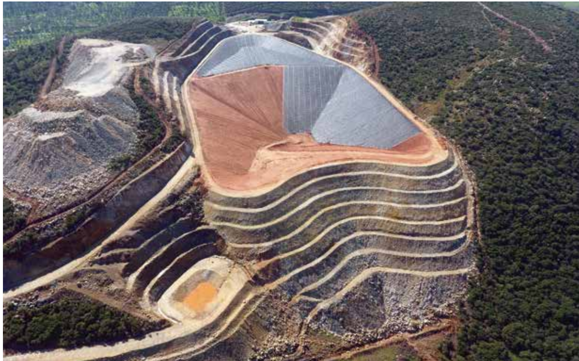
BentoShield ile maden atık sahasında geçirimsizlik tabakası oluşturulmuştur.
